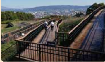
スロープデッキ (空中歩道)
